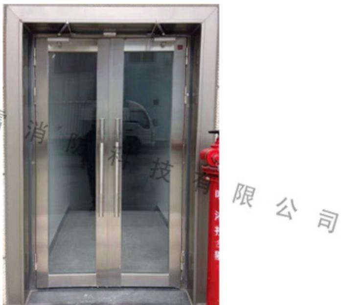
目前国内钢质防火门按使用要求和规格型号分为：单扇、双扇，单扇带玻、双扇带玻，单扇带亮窗、双扇带亮窗，单扇带玻带亮窗、双扇带玻带亮窗八个品种。其中，具性的就是带玻璃或带亮窗防火门，它的基本结构是：门框用钢板(冷轧或镀锌等)制作，门扇两面面板为钢板(冷轧或镀锌等)，部分防火门两面板内侧会内衬无机不燃防火板，门扇内的加强筋为冷轧钢板，加强筋与面板之间用点焊连接，门扇内填充隔热材料(不同容重的硅酸铝纤维棉、岩棉等)。门扇镶玻璃及亮窗玻璃均采用与门的耐火性能等级相同的防火玻璃，门框槽口及门扇中缝处安装密封材料(防火膨胀密封条、硅酸铝纤维毡等)。另外还要安装不同功能的防火锁、铰链、闭门器、顺序器、释放器、插销等。所有配备的五金产品件都必须是通过国家固定灭火检测中心检测合格的产品。张店超大防火门价格智雷消防科技采用先进的加工工艺，进行加工研发。
